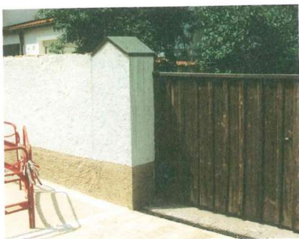
Einfriedung als Mauer
